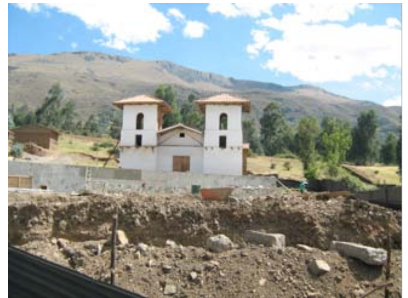
Foto 2. Plaza en construcción del centro poblado de Huamantanga,
